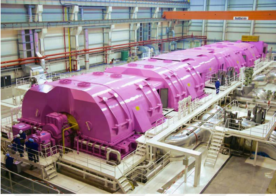
Şekil 6.13 VVER-1200 reaktör türbini (Rosatom, 2006)
