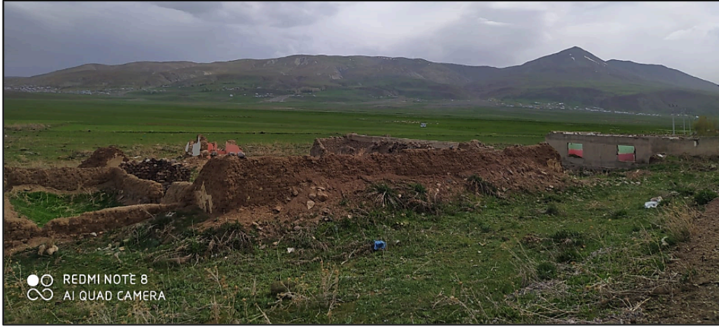
Foto 7. Göç Eden Bir Aileden Kalma, Terkedilmiş Konut ve Eklentileri (Aşağı Sağmalla Mevkii)
