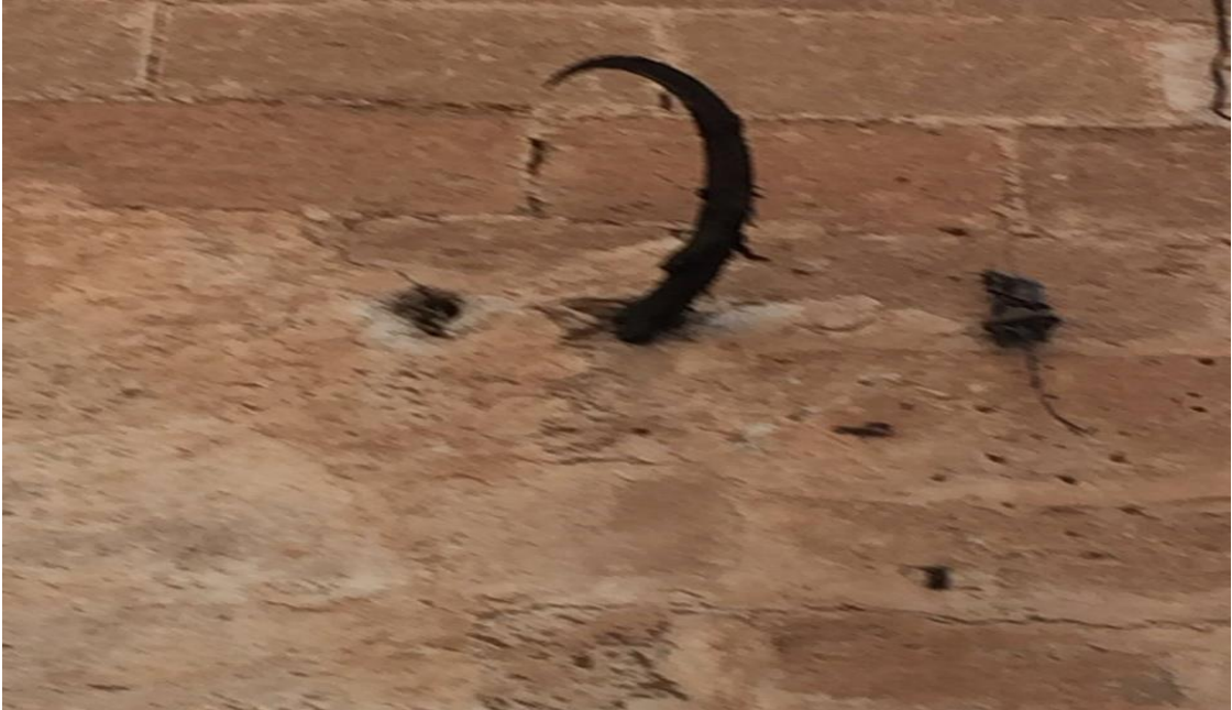
28) Nazardan korunmak için evin duvarına monte edilmiş koç boynuzları. Çok eski olduğu için bir tanesi düşmüş. (120 Numaralı kaynak kişiden izin alınarak çekilmiştir.)
