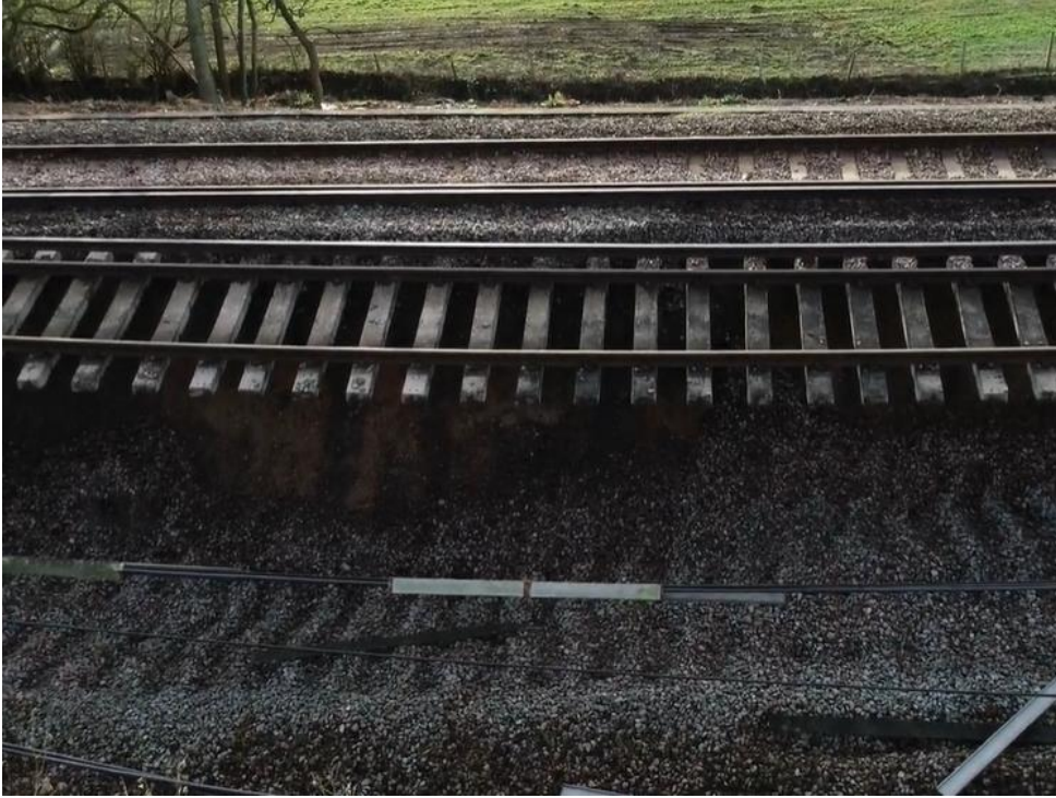
Şekil 1.4. Balast eksikliği
