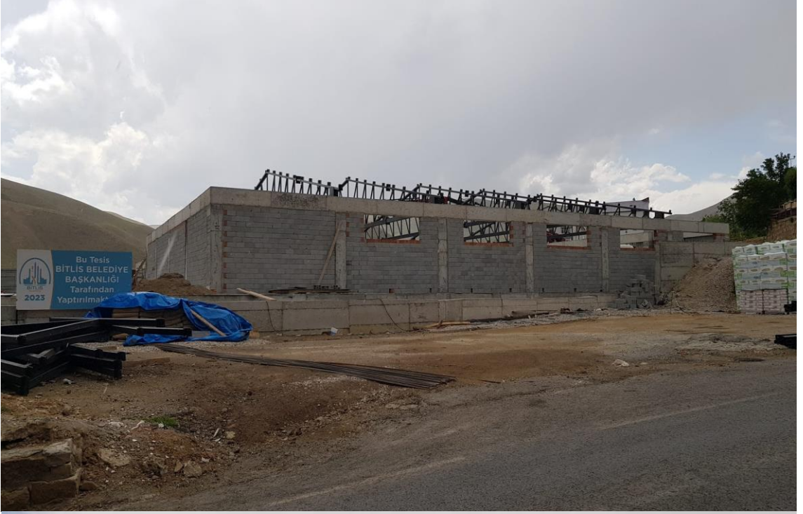
Fotoğraf 5.8. Yeni Yapılacak Bitlis Merkez Spor Salonu İnşaatı (2023)
